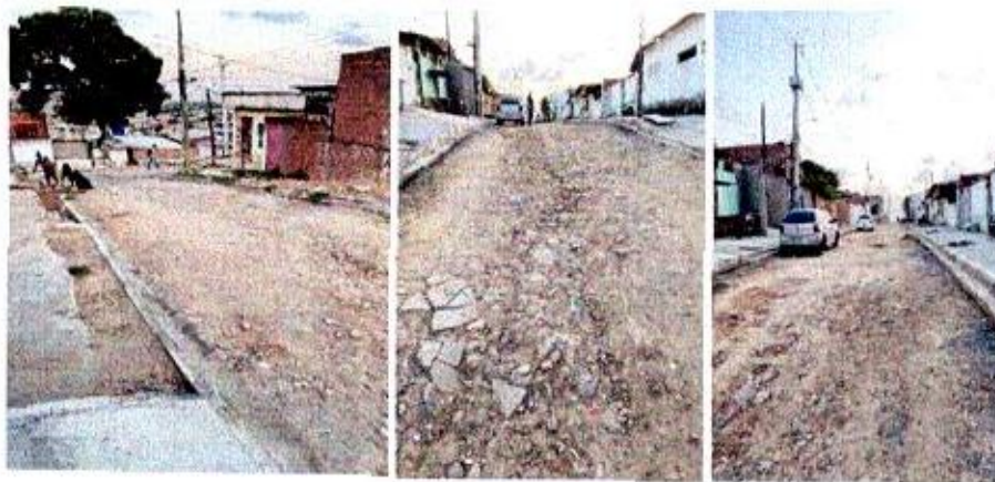
(registro fotográfico do local)
